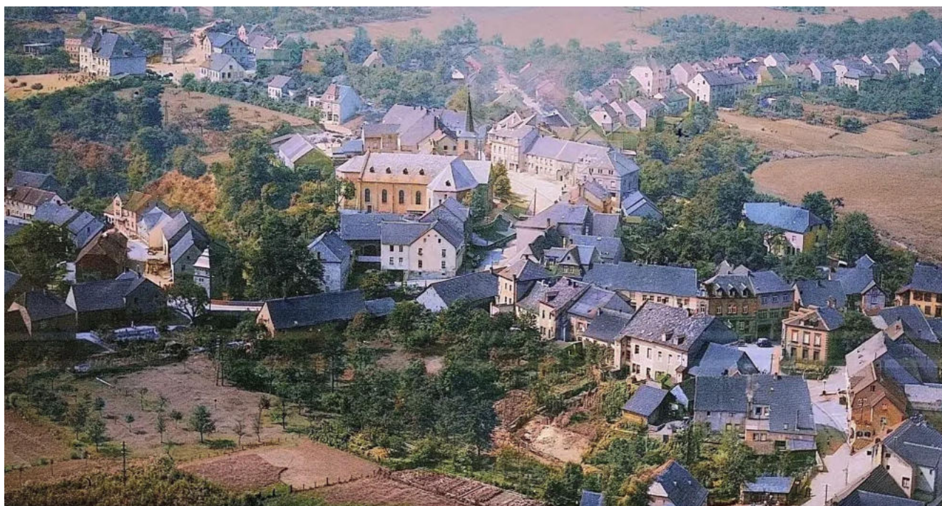
Ortsmitte Eppelborn ca. 1935 mit der der Pfarrkirche St. Sebastian in der Mitte, eine Aufnahme des Hansa-Verlages Abbildung: Förderkreis für Heimatpflege und Denkmalpflege e.V. Eppelborn
