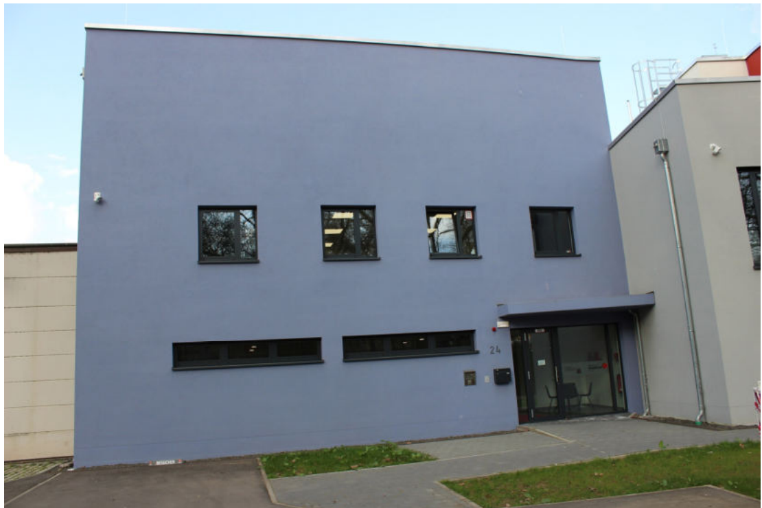
Das neue Gebäude des Stadtarchivs Neunkirchen an der Norduferstraße.
