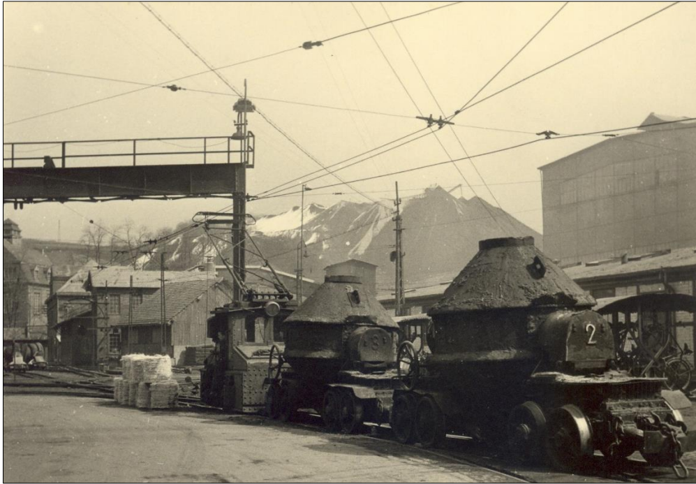
Das Titelbild des Kalenders der Geschichtswerkstatt Brebach für 2024 zeigt einen Zug der Werksbahn auf dem Weg zwischen den Hochöfen und einer der Gießereien. Im Hintergrund ist die schneebedeckte Schlackenhalde der Halbergerhütte, am linken Bildrand das Arbeiterheim am Alten Werk zu erkennen (Foto: Werksarchiv Saint-Gobain PAM Deutschland).
